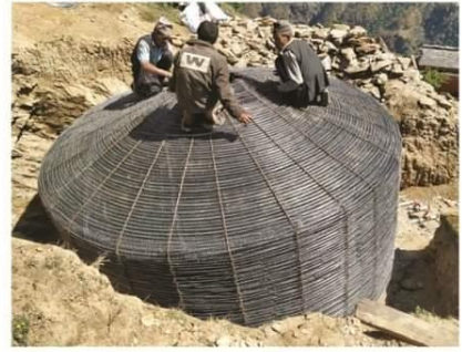
दिलेकको भगवतीमाई गाउँपालिका-४ मा निर्माणधिन खानेपानी आयोजनाको त्रिचम टुप्पाको निर्माण गर्दै कामदार ।
